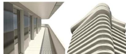
Figure 21 - Protections solaires intégrées par l'architecture : balcons et terrasses aux lames verticales.
