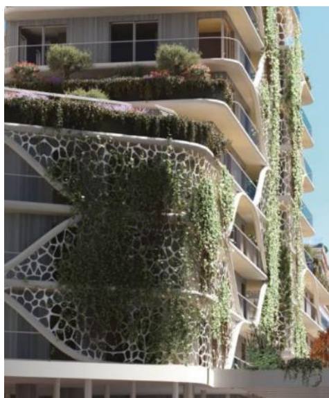
Exemple de résille en façade Larvotto Supérieur – Construction logements collectifs
