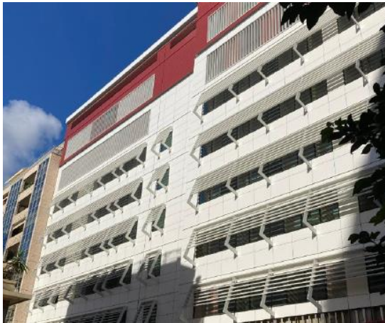
Exemple de brises soleil fixes à lames horizontales Réhabilitation/Surélévation de la Direction de la Sécurité Publique
